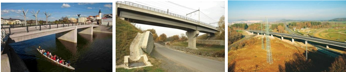
Obrázek 2.2: Příklady trámových mostů v Přerově (2), v Jablunkově (3) a v Sosnové (3).
