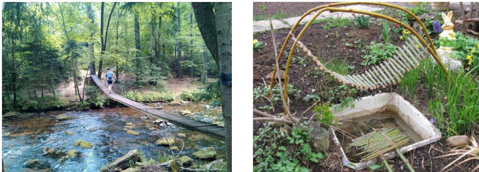
Obrázek 4.1: Jednoduchá lanová lávka přes řeku Zdobnici u Vamberka (11) a model jednoduchého visutého mostu z vrbového proutí a provázků (1).
