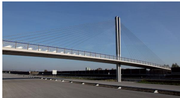
Obrázek 4.3: Zavěšený lanový most na Peloponés, Řecko (13), a zavěšená lanová lávka přes dálnici D1 v Bohumíně (14).
