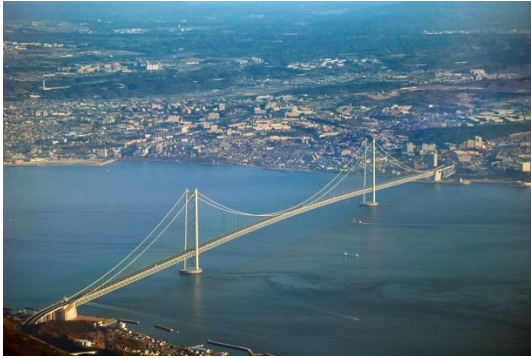
Obrázek 4.2: Visutý lanový most se zavěšenou mostovkou Akaši-Kalikjó s nejdelším rozpětím hlavního pole (1991 m, Kóbe, Japonsko) a řetězový most přes řeku Dunaj v Budapešti (12).
