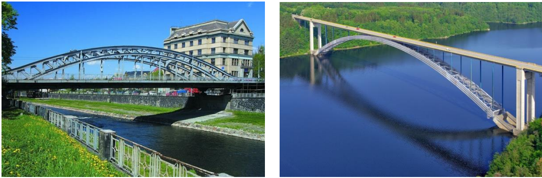
Obrázek 3.3: Ocelový obloukový most Miloše Sýkory s dolní mostovkou přes řeku Ostravici v Ostravě (9) a Žďákovský most přes vodní nádrž Orlík na Vltavě s horní mostovkou (10).
